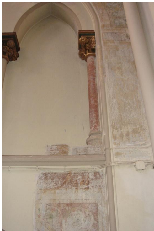
Op deze foto is de oude bekabeling nog goed te zien.
